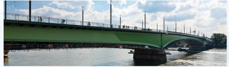
Die Kennedybrücke wurde 2013 saniert und ist 394 Meter lang und 26 Meter breit (vor Sanierung 18 Meter).
