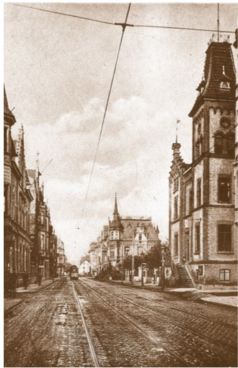
Friedrichstraße mit altem Rathaus (im Bild rechts)
