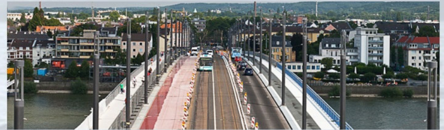
Die Kennedybrücke wurde 2013 saniert und ist 394 Meter lang und 26 Meter breit (vor Sanierung 18 Meter).
